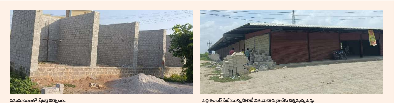
పసుములలో షేటర్ నిర్మాణం.. పెద్ద అంబర్ పేట్ మున్సిపాలిటీ విజయవాడ హైవేకు నిర్మిస్తున్న షెడ్డు.
