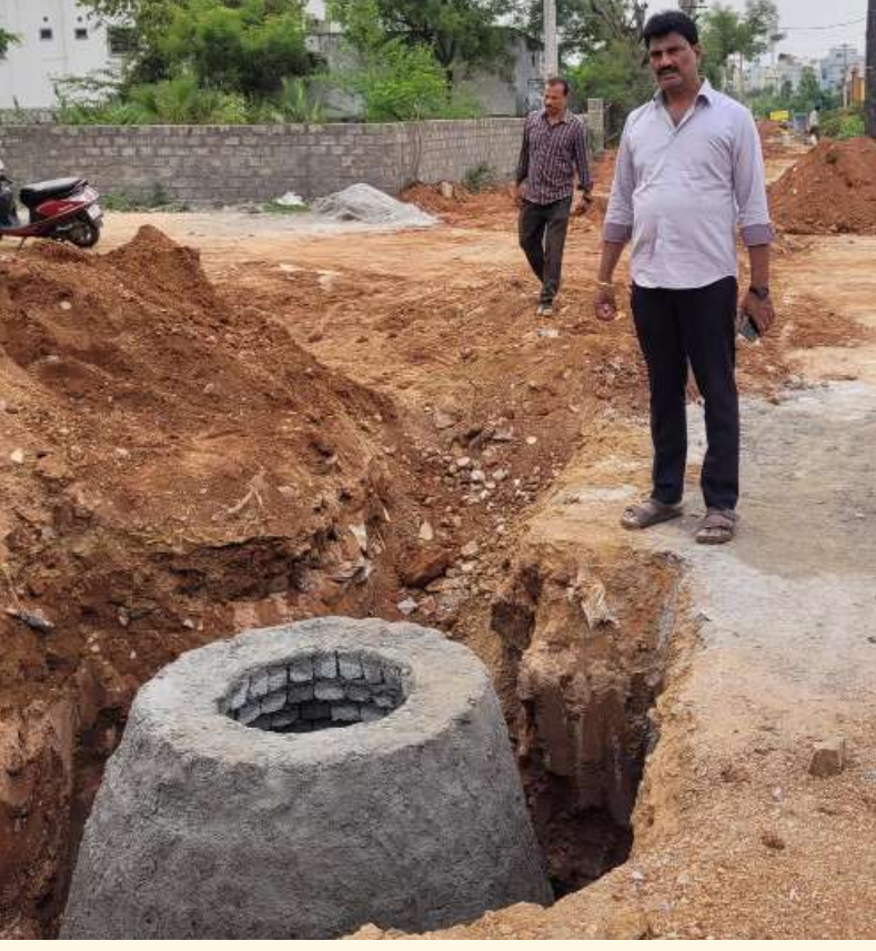
బి.యన్ రెడ్డి నగర్ డివిజన్ పరిధిలోని ఆఫీసర్స్ కాలనీలో జరుగుతున్న భూగర్భ ద్వైవేజ్ పనులను బి.యన్.రెడ్డి నగర్ డివిజన్ జిహెచ్ఎంసి కార్యకర్తల ముద్దుల బిచ్చి రెడ్డి పర్యవేక్షించడం జరిగింది
