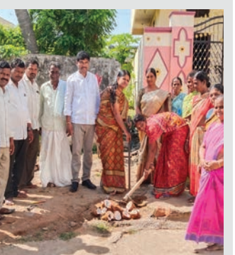
అండర్ గ్రౌండ్ డ్రైనేజీ నిర్మాణం
